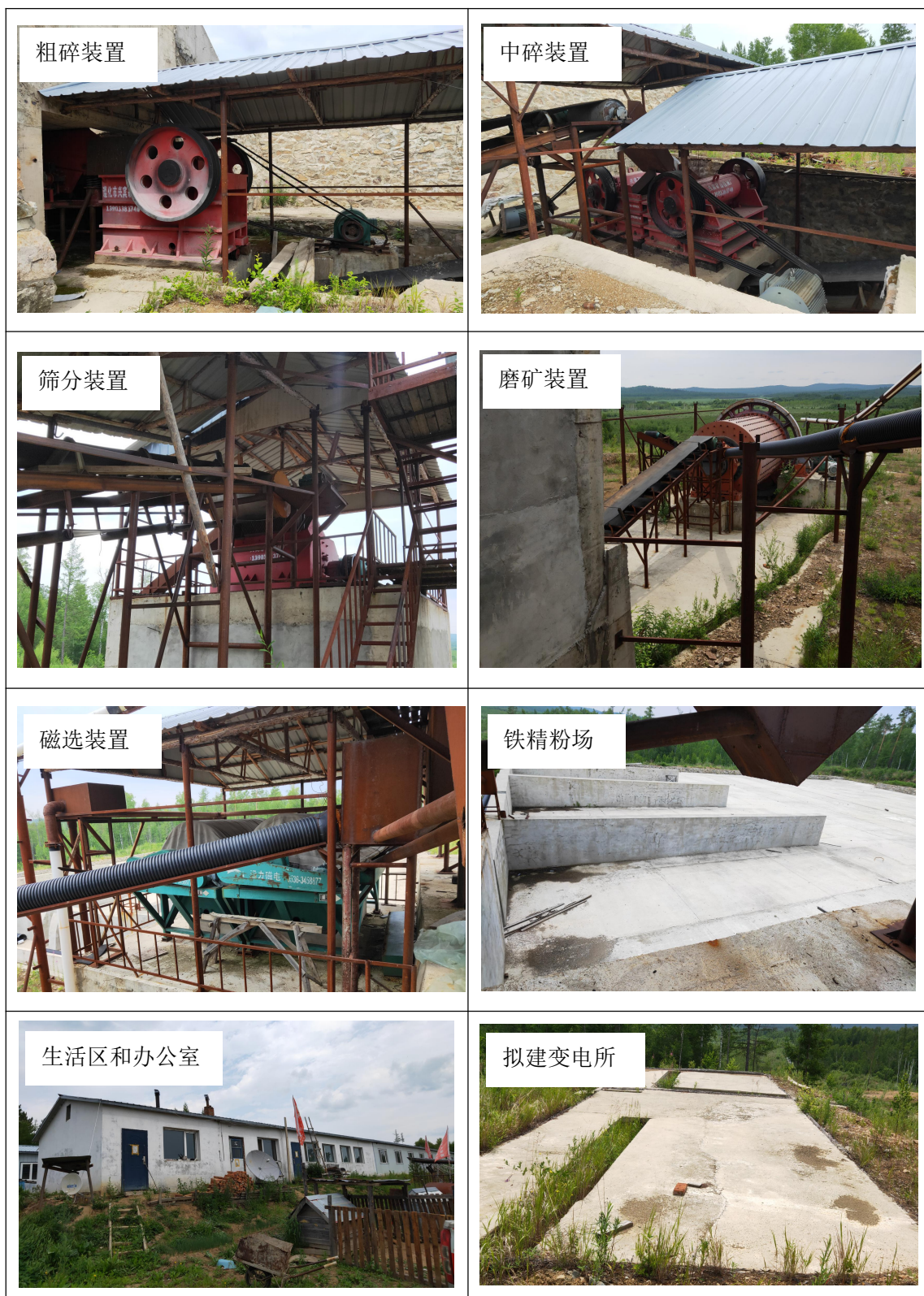
图 3.1-1 本项目选矿厂现状图
